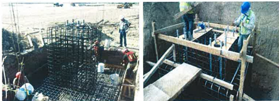
FIGURA 3. EJEMPLO DE CIMENTACIÓN SUPERFICIAL
