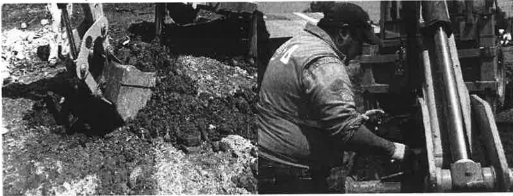
Figura 37 Toma de muestra en pozo donde se ubicará la maquinaria
