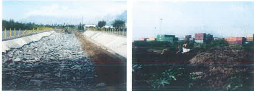
FIGURA 1. EJEMPLO DE DEMOLICIÓN Y LIMPIEZA DE TERRENO
