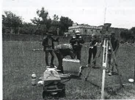
Figura 19 Estación de punto base
