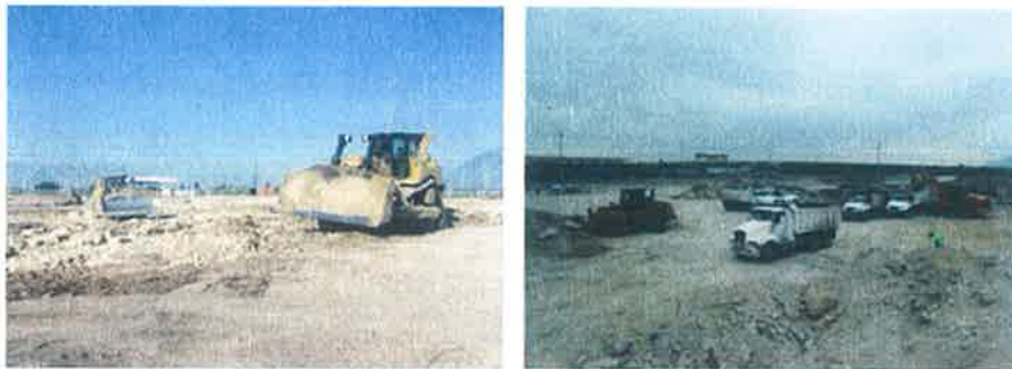
FIGURA 2. EJEMPLO DE CORTE Y ACARREOS
