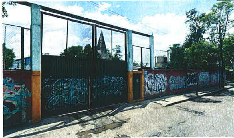
FIGURA 17. ACCESO ACTUAL AVENIDA 5 DE MAYO #150
